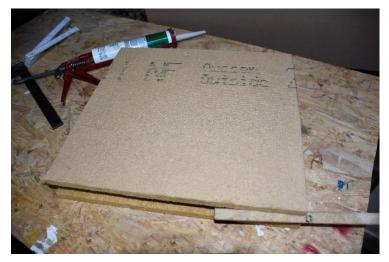
beim Zuschnitt etwa 2mm Luft, so bauen sich keine Spannungen auf, falls die neue Halbzarge später noch schrumpft.
